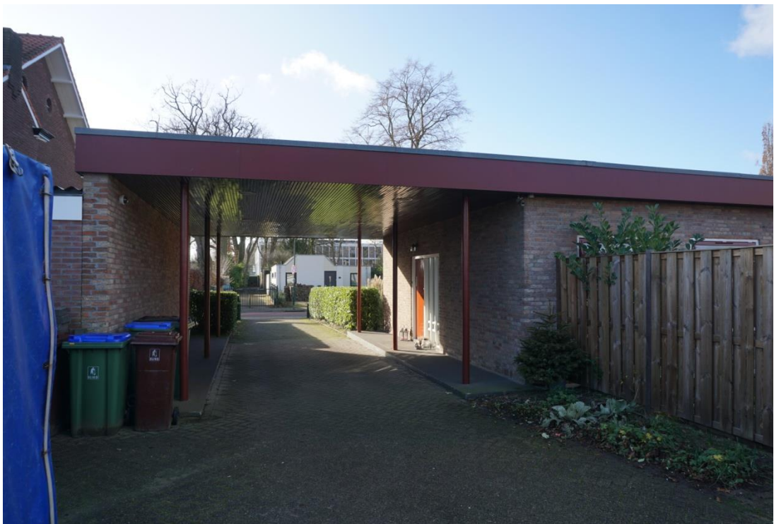
Oostgevel van de oostvleugel
