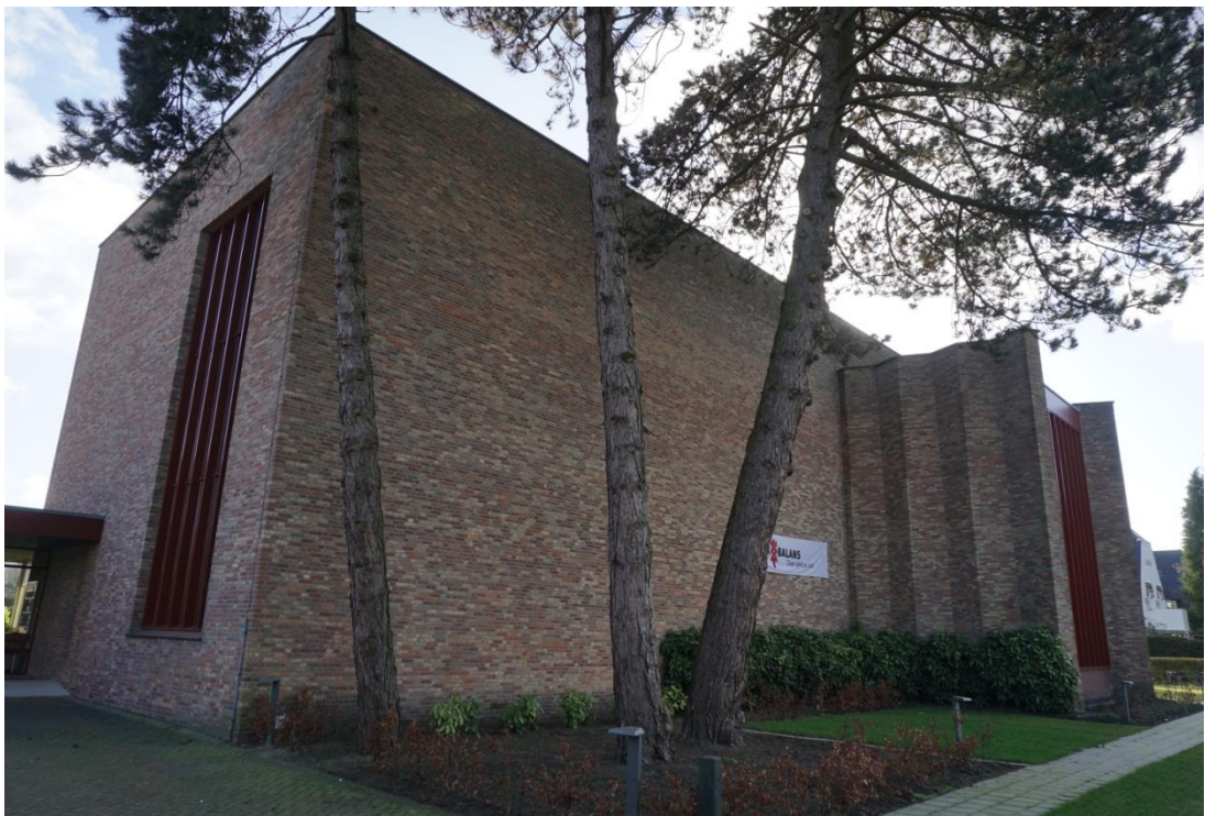
Noord- en westgevel van de kerkzaal
