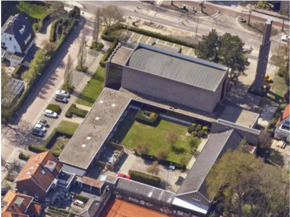
Luchtfoto richting het westen
