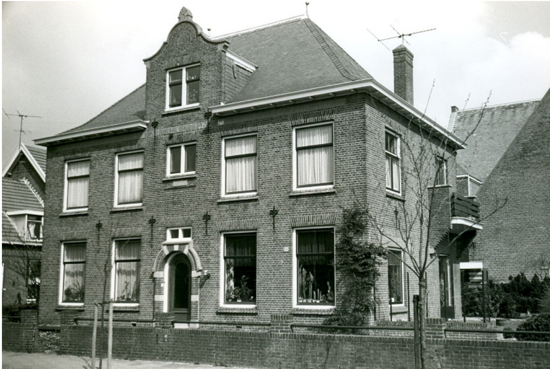
Afb. 25 - De pastorie halverwege jaren zestig. Ds. Ferwerda was de laatste predikant, die hier heeft gewoond. Hij vertrok in de eerste helft van de negentiger jaren naar een flat aan de Mercuriusstraat. Van 1 juni 1984 tot 1 december 2006 is het in gebruik geweest als gezinsvervangend tehuis (Stichting Bollenstreek voor Dagverblijven en Tehuizen) en vervolgens diende het tijdelijk als huisvesting voor mensen uit Polen, die hier via een arbeidsbureau (tijdelijk) werk hadden gevonden. In 2009 is het pand verkocht en thans is er een praktijk voor fysiotherapie gevestigd.
