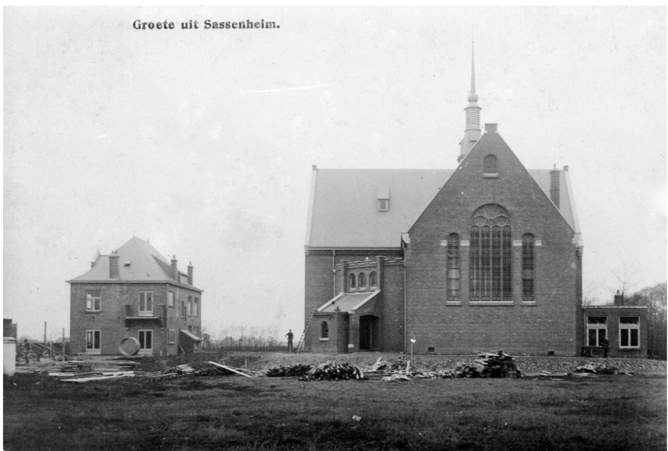
Afb. 8 - Foto begin 1912. Gezicht op de in aanbouw zijnde kerk vanaf de Hoofdstraat. De bouw van de kerk is bijna klaar. Het open stuk op de voorgrond is nog leeg. Daar zal in 1925 W. Spielman een villa laten bouwen, de tegenwoordige villa 'Beukenhof'.
