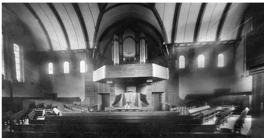
Afb. 15 - Interieur van de kerk in de periode van 1928-1958. Links- en rechtsachter zijn de 'hoge banken' te zien. Deze zijn later bij de restauratie in 1992 verwijderd.
