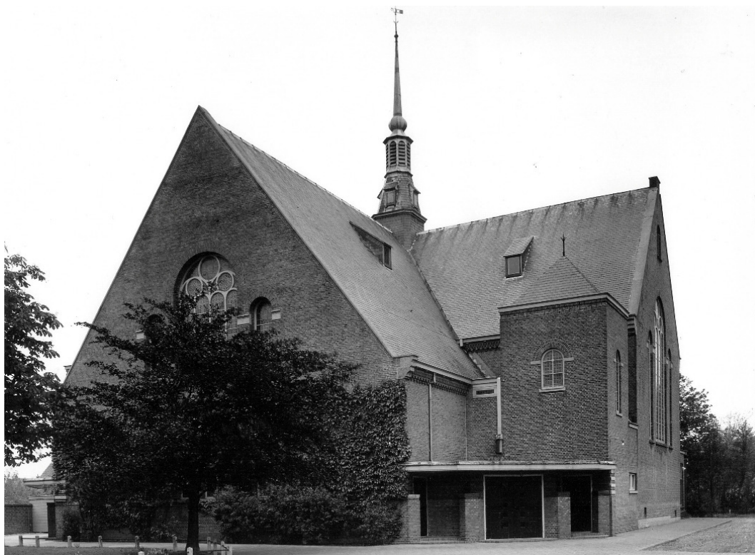
Afb. 14 - Buitenaanzicht van de kerk na de verbouwing in 1927- 1928. De foto is van ca. 1958.
