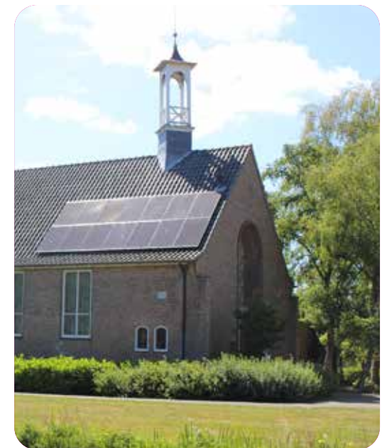
voorbeeld van kerkdak met zonnepanelen
